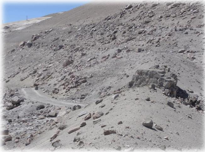
Foto 5: Los indicios de una vía férrea a una altitud superior a la de la foto 4. A partir del centro inferior, se puede detectar un antiguo terraplén, por el cual se habría tendido una vía férrea, la que cruzó el camino mediante un puente, con soportes de piedra, cuya viga ya ha desaparecido, seguramente desarmada para chatarra. (©ithomson, 04/14)
